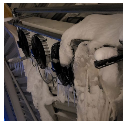
Figur 25 - Friluftaggregat for isvannkjøling utendørs (v.f uten isbygging, v.h med isoppbygging)
