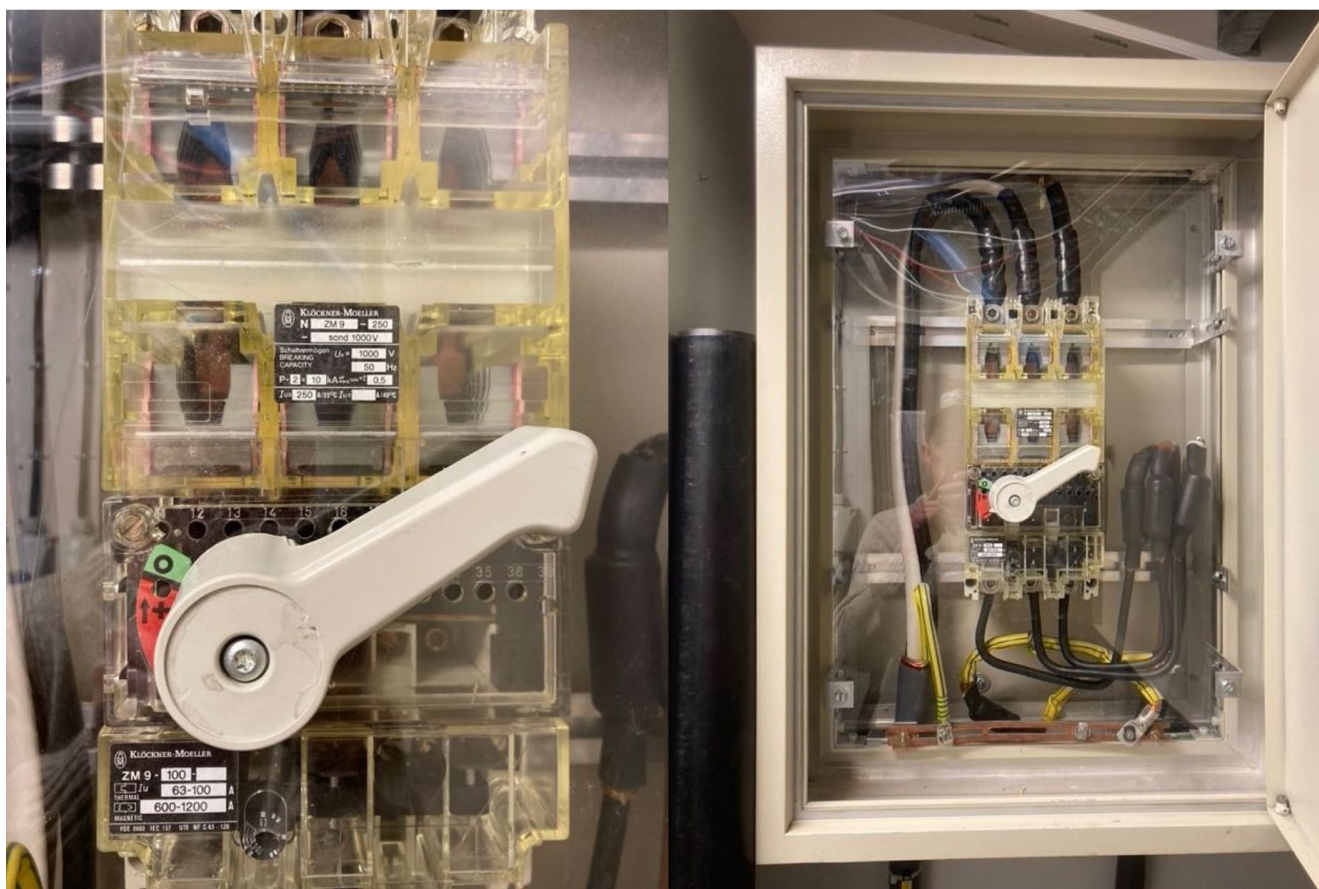
Figur 4 - Effektbryter Klöckner+Moeller ZM9-250 sond 1000V & ZM-9-100 [8].
