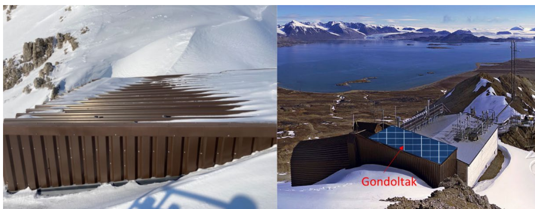
Figur 62 - Tak over gondoltunnel, lengde på 7.45 meter og bredde på 4,5 meter
