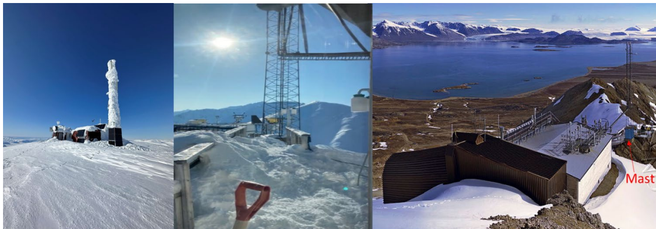
Figur 63 - T.v Tilsvarende installasjon på Skolten (Telenor), m og t.h NILU mast Zeppelin med bredde på 90cm.
