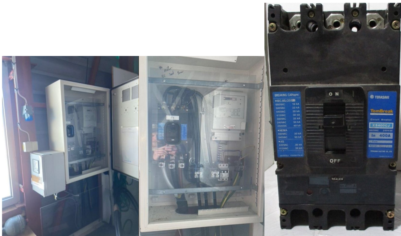
Figur 3 - Effektbryter Terasaki XS400CJ for Zeppelinobservatoret plassert i gondolbygget [8].
