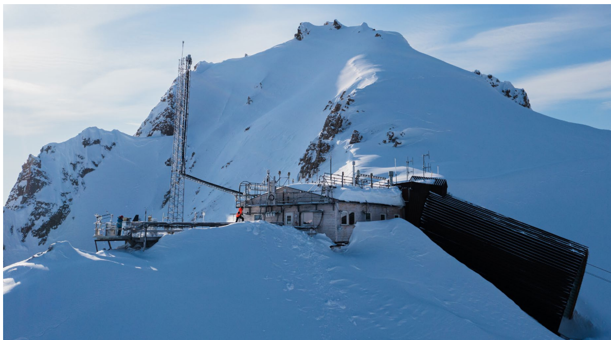
Figur 68 - Dronefoto fra April 2023, viser byggets øst og nordside. Foto av Trine Lise Sviggum Helgerud
