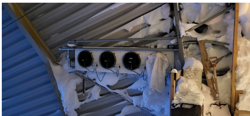
Figur 25 - Friluftaggregat for isvannkjøling utendørs (v.f uten isbygging, v.h med isoppbygging)
