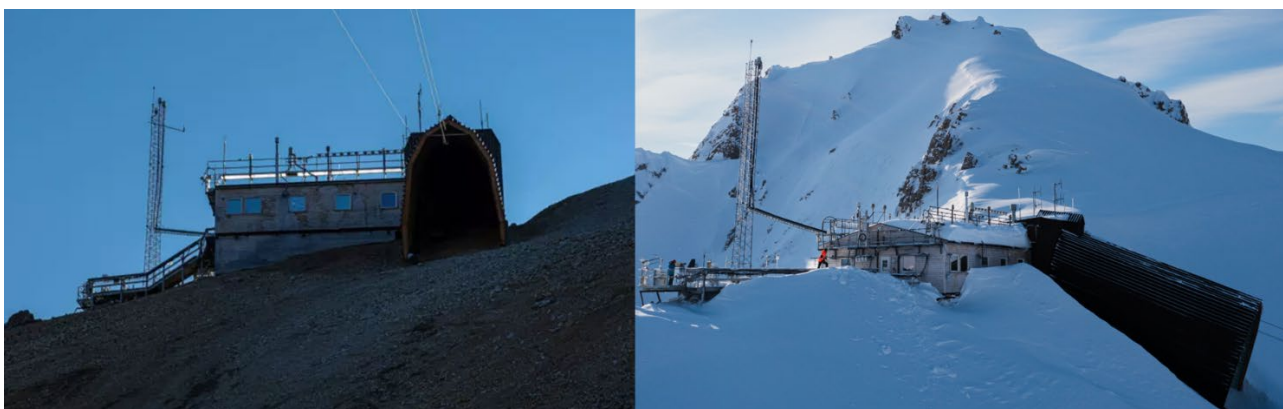
Figur 65 - Vegg mot nord.
